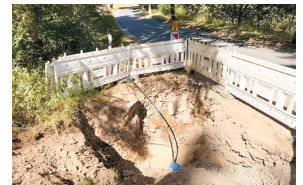
In Maulusmühle werden neue Wasserleitungen verlegt. © Claude Bertermes
