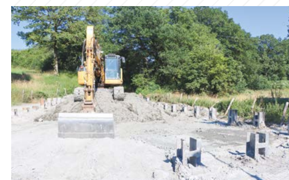
In Rümlingen und Stockem laufen Kanalarbeiten für das zukünftige Regenüberlaufbecken in Stockem.
