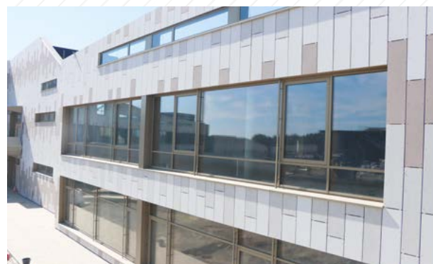
Die Arbeiten im Außenbereich des neuen Bildungshauses in Wintger werden weitergeführt. © Fernand Arend
