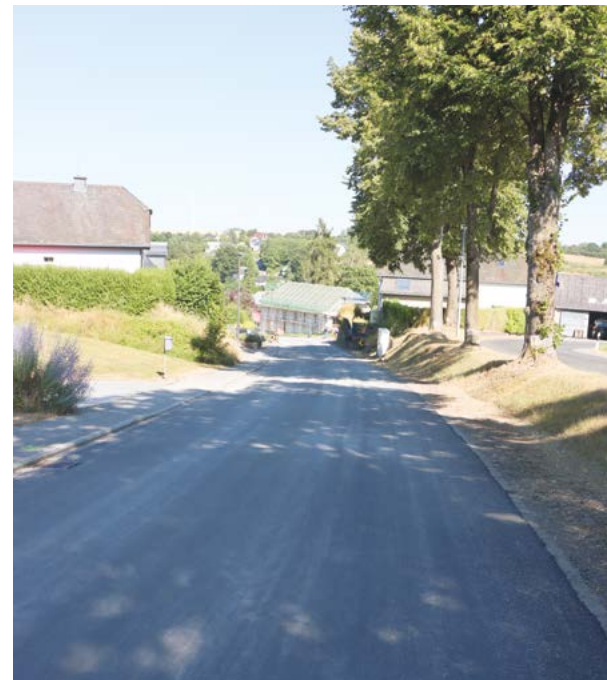
In Doenningen wurde der Straßenbelag erneuert.
