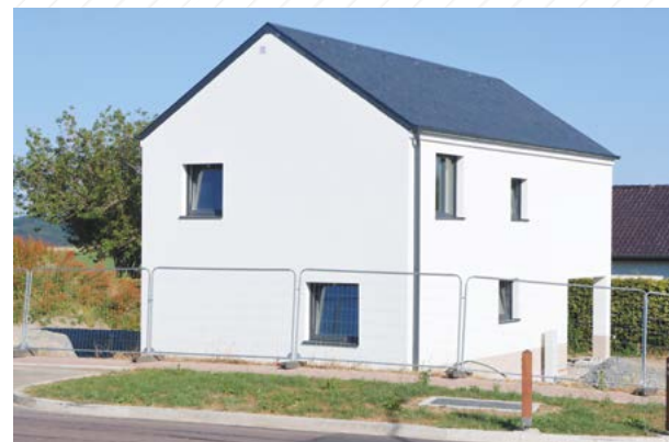
Die Bauarbeiten für die Häuser in Heisdorf, im Rahmen des Projekts „nachhaltigen und bezahlbaren Wohnraum“ haben gestartet.
