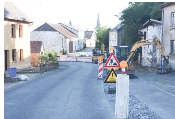
In Trotten wurden Glasfaserleitungen von Post verlegt. © Fernand Arend
