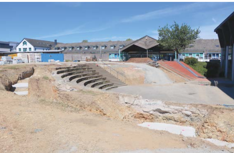
Das Amphitheater wird umgebaut und vorbereitet für die Arbeiten am Überdach.
