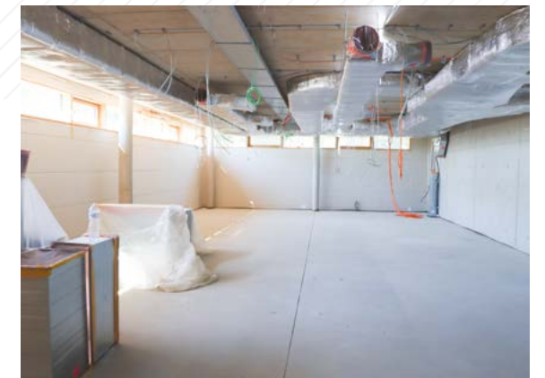
Die Innenarbeiten des neuen Bildungshauses in Wintger kommen voran. © Fernand Arend
