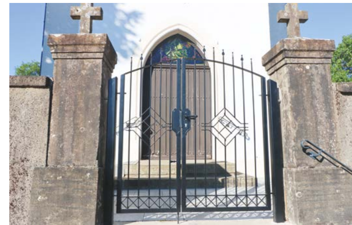
In Derenbach wurde das Eingangsportal der Kirche erneuert.
