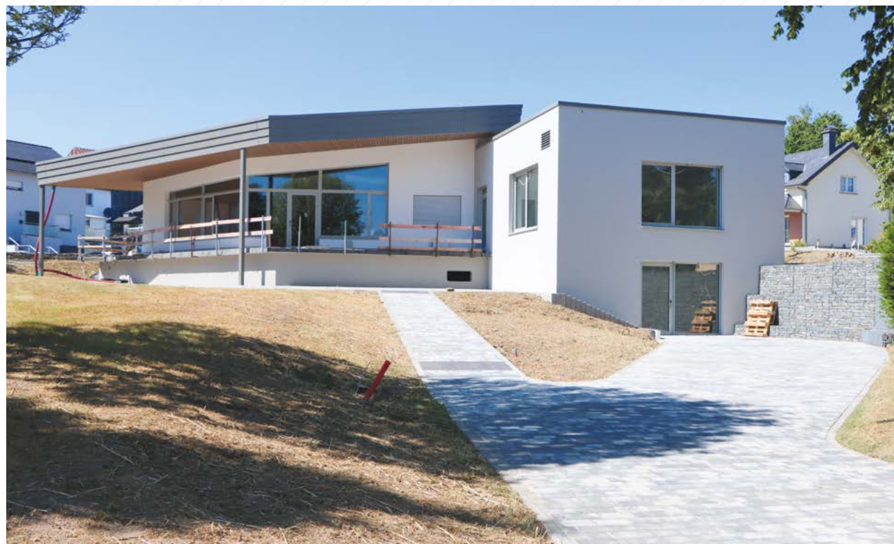
Die Arbeiten im neuen Festsaal in Asselborn gehen vorwärts. Diese sollen im Herbst beendet sein. © Fernand Arend
