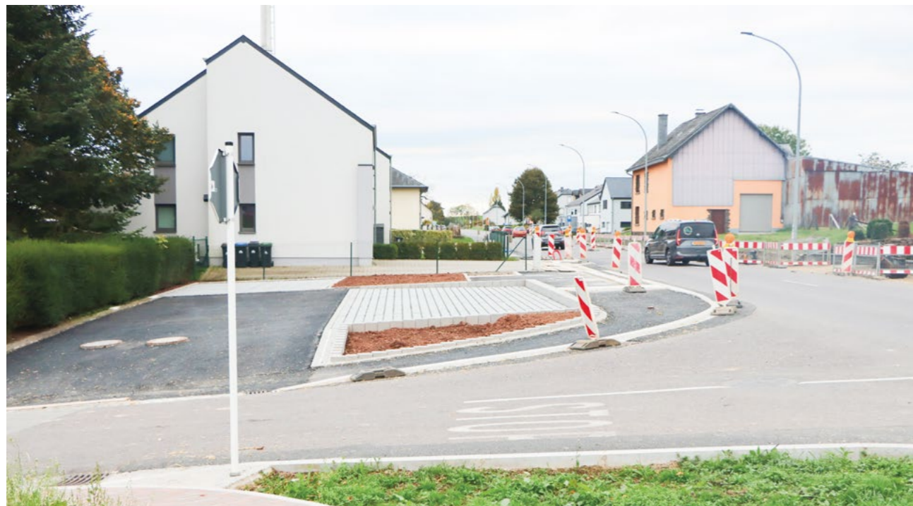
Errichtung einer Bushaltestelle mit Parkplätzen in Heisdorf. Ein Fußgängerüberweg mit Ampeln wird noch eingerichtet. © Fernand Arend
