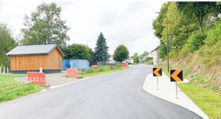
Die Straßenarbeiten in Boxhorn sind fertig. © Claude Bertemes
