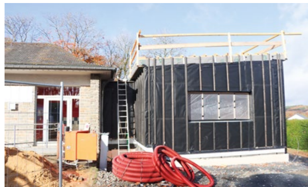
In Helzingen kommen die Arbeiten für die Minicrèche voran. © Fernand Arend
