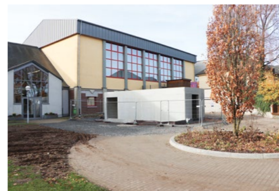
Bau einer Kabine für einen Transformator. © Fernand Arend
