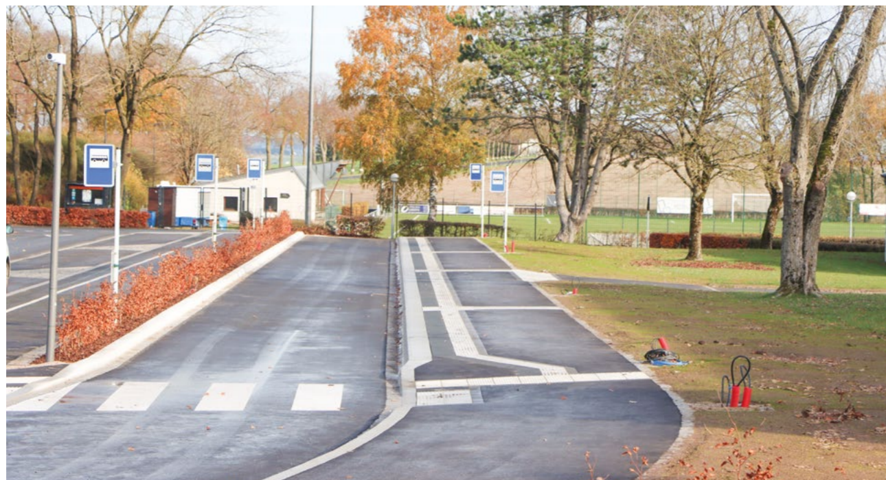
Die Arbeiten für die Bushaltestellervergrößerung an der Wintger Schule sind beendet. © Fernand Arend
