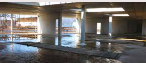
Bildungshaus in Wintger: Der Hauptteil der Betonarbeiten ist abgeschlossen. Die Arbeiten für Fassade, Fenster und Dach haben im Januar/Februar 2025 begonnen. Die Arbeiten für die Elektrik Heizung/ Lüftung/Sanitär sollen ab März/April 2025 beginnen.
