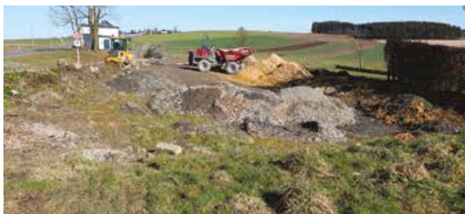
Logements abordables à Heesdref – Le début des travaux est prévu pour mai 2025, avec une remise des clés au courant de l'année 2027! Les inscriptions sont toujours ouvertes et les formulaires dédiés peuvent être téléchargés sur le site internet de la Commune. Informations et renseignements: 26 00 22 - 221 www.wincrange.lu , rubrique «Logements abordables»
