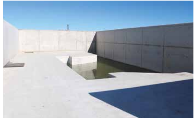
Die Betonarbeiten am Wasserbehälter "Féitsch" sind abgeschlossen.
