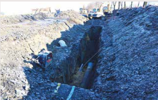
Zur Zeit wird von der DEA eine Wasserleitung verlegt von Derenbach bis nach Huldigen.
