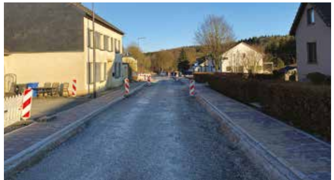
In Boxhorn sind die Kanalarbeiten in der „Hauptstrooss“ in Richtung Clerf so gut wie abgeschlossen. Die Bürgersteige und die Strassenarbeit sind im Bau.
