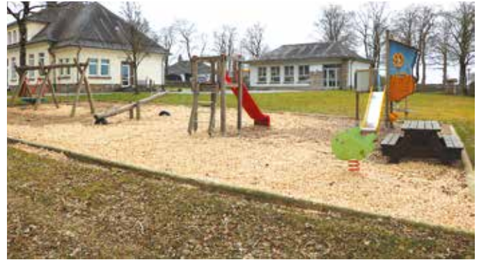
Der ehemalige Kindergarten in Helzingen soll zu einer „Minicrèche“ umgebaut werden.
