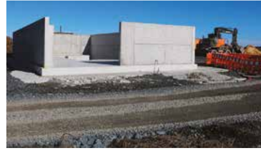
Die Betonarbeiten am Wasserbehälter "Féitsch" sind abgeschlossen. Das Verlegen der Leitungen in Richtung Trotten-Straße und Heisdorf ist in Fertigstellung.
