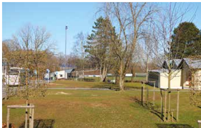
Ausbau der Bushaltestelle der Grundschule in Wintger
