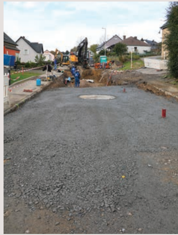
An der Hauptstrooss zu Boxer waerten Kanal-Waasser-Elektrisch-Post-Arbichten bis gudd an d'Joer 2025 undauern bis datt d'Strooss matt neien Stroossenluuchten an Trottoir faerdig waert sin.
