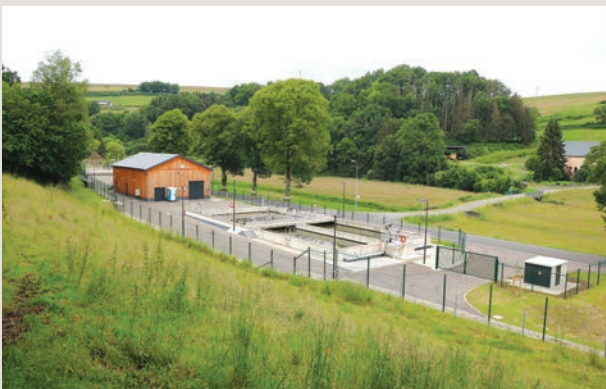
Das Rückhaltebecken in Asselborn ist weitestgehend fertiggestellt. Nach Inbetriebnahme der Kläranlage in Sassel kann das Wasser dort in die Anlage fließen.
