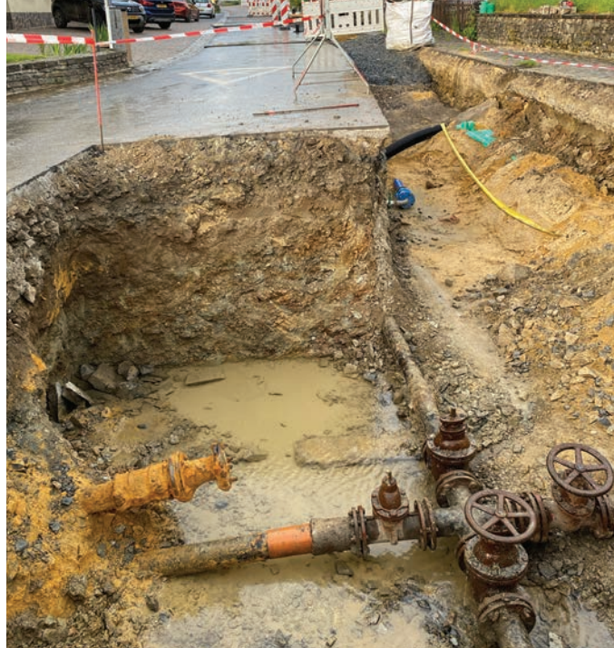
Die alten Wasserleitungen in Boxhorn.
