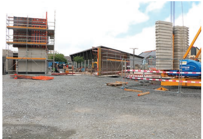
Grosse Baustelle auf dem Gelände der Wintger Schule.
