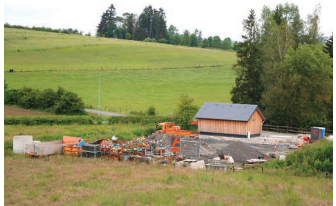
Regenüberlaufbecken in Emeschbach.
