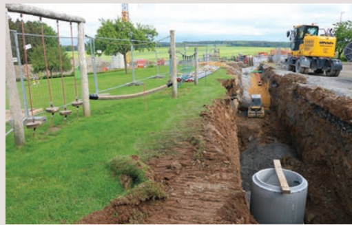
Wintger – Regenüberlaufbecken Schulgebäude und Kanalarbeiten entlang der Einfahrt zum Centre Culturel und Schwimmbad.
