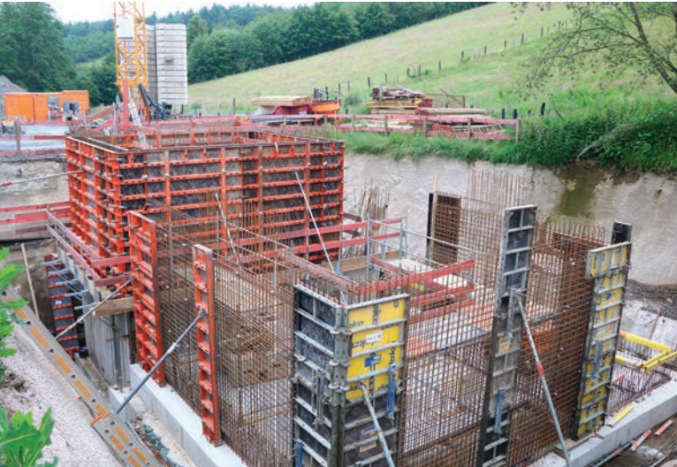
Boxhorn Rückhaltebecken (in Richtung Klerf): Die Betonarbeiten laufen.
