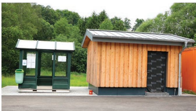
Der Bau des Regenüberlaufbeckens in Sassel dient in erster Linie dazu, die Einleitungen von unzureichend verdünntem Abwasser in die hochsensible, als „Natura 2000“-Gebiet eingestufte aquatische Umwelt deutlich zu reduzieren.
