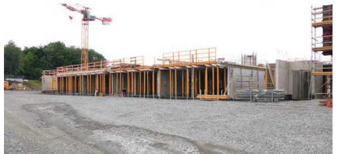
Bildungshaus Wintger: Die Betonarbeiten laufen. die Infrastrukturarbeiten werden beginnen. Die Dach- und Fassadenarbeiten am Gebäude „E“ werden voraussichtlich um den Monat November 2024 beginnen.
