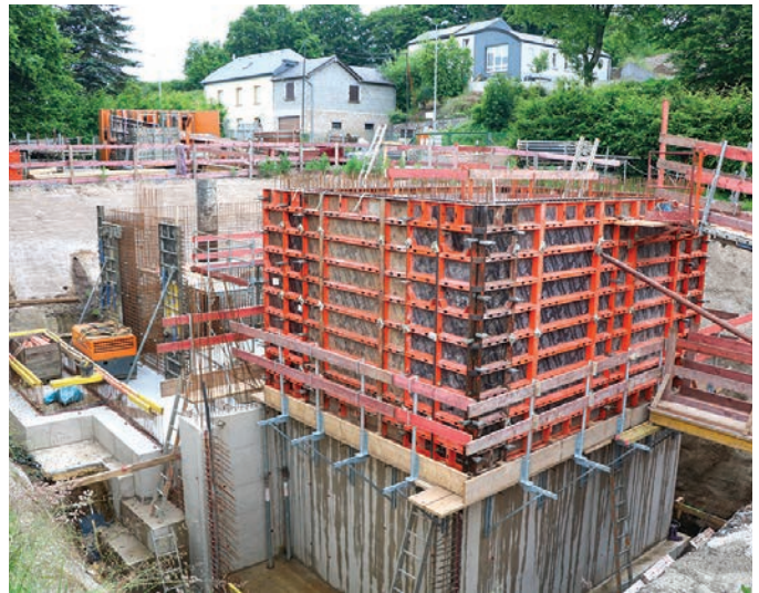
Bassin de rétention en construction à Boxhorn.
