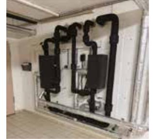
Ein Wärmetauscher für warmes Wasser in der Sporthalle und eine separate Station für die Küche.
