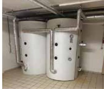
Ein neuer Pufferspeicher um frisches Wasser aufgeheizt zu haben bei Bedarf, somit bleibt kein "stehendes Wasser" mehr im Boiler und funktioniert demnach hygienisch Ordnungsgemäss.
