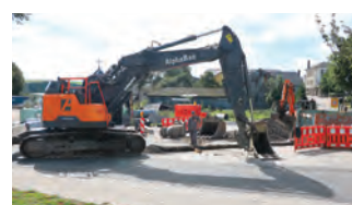
Chantier Rüb Asselburren
