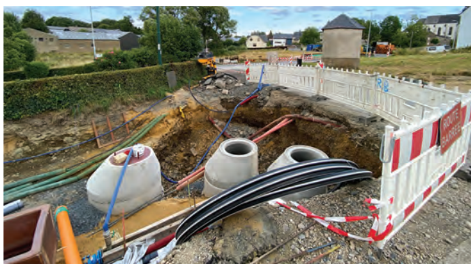
Boxhorn, Straßenarbeiten: Die Baustelle hat begonnen.
