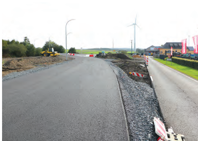
Le rond-point Féitsch est en construction.
