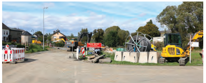
Chantier zu Boxer "A Pëtzen"
