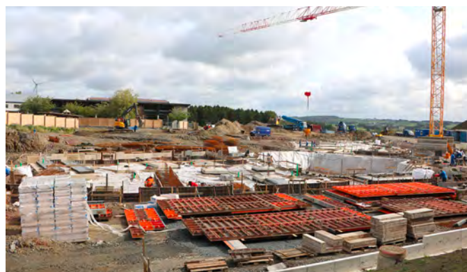
Chantier vum Bildungshaus Wëntger.
