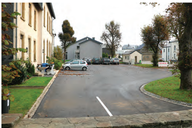
La cour de l'ancienne école d'Asselborn a été redressée avec un nouveau macadam.
