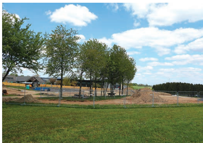
Chantier Bildungshaus zu Wöntger
