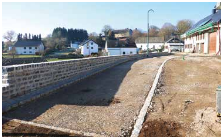
Zu Béigen gëtt eng Stützmauer gebaut.
