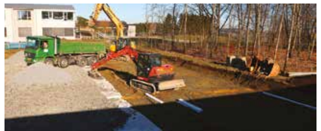
Chantier Eimeschbach Reeniwerloofbecken an Kollektoren déi vom Haus Heisten Richtung Aasselburren gelaat gien
