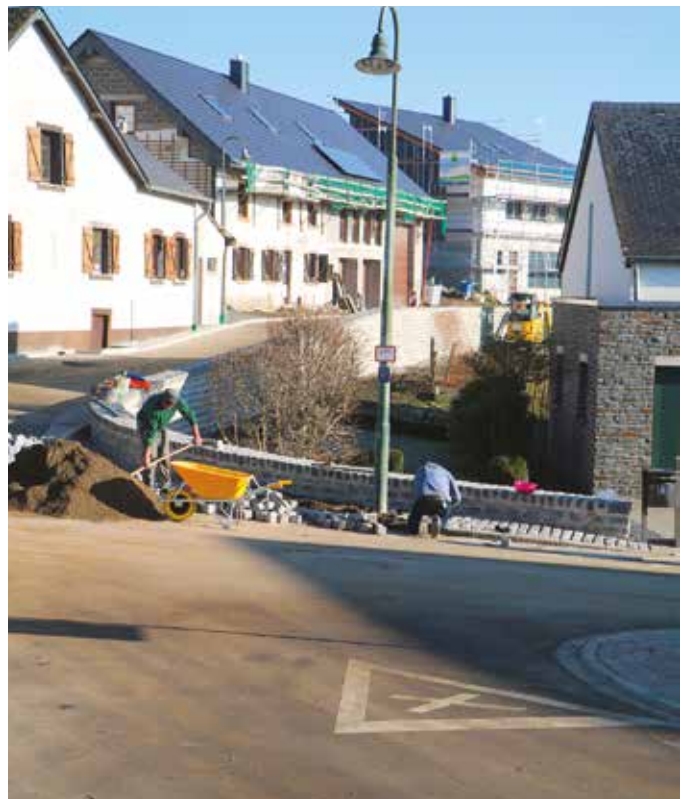
Zu Béigen gött eng Stützmauer gebaut.
