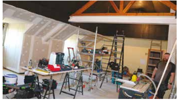
Sitzungssall Gemeinjenhaus gëtt renovéiert an nei isoléiert.
