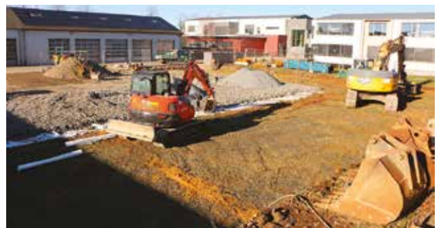
Den Neien Atelier zu Wëntger, den Bagger leeft
