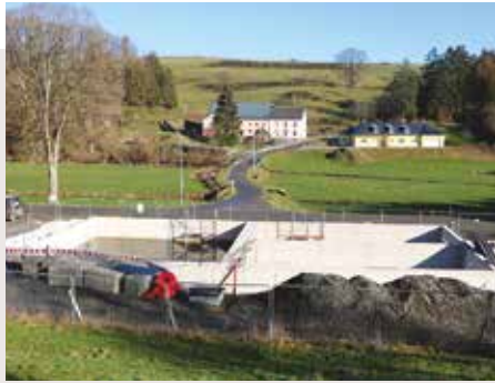
Chantier Sassel Reeniwerloofbecken an Kläranlage
