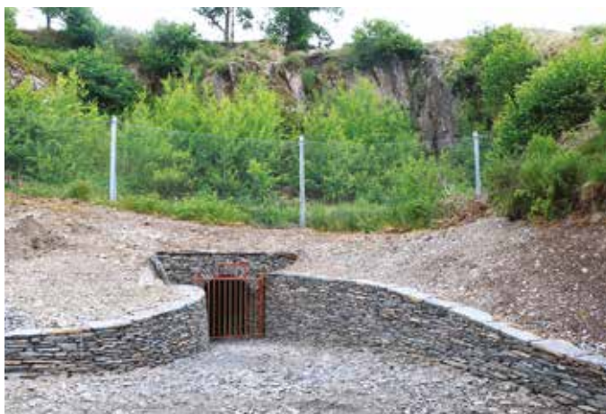
D'Entrée van op der Éimeschbaacher "Leekaul" ass befestigt gin.
