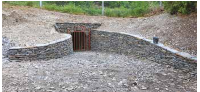
D'Entrée van op der Éimeschbaacher "Leekaul" ass befestigt gin.
