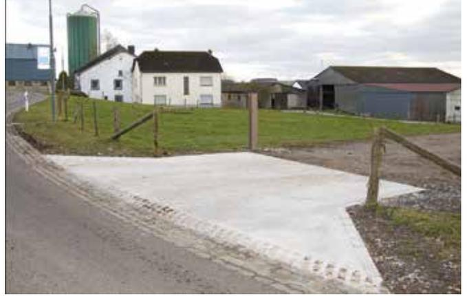
Weiler, vis a vis vom Busheischen hott Gemeng eng Platz betonéiert fir datt Kanner kannen sécher an den Bus raus a raklappen
