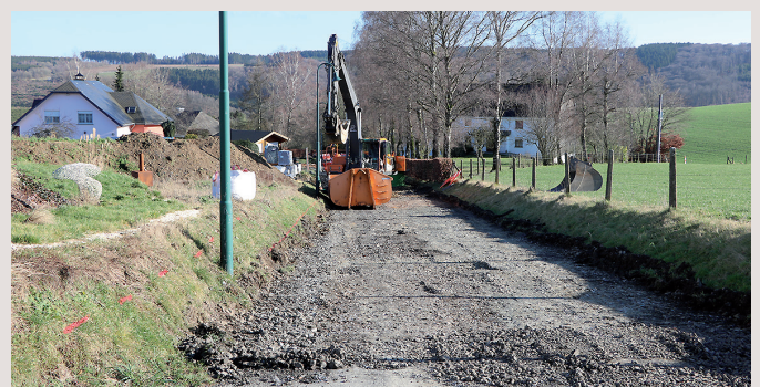
Zu Béigen „Om Knupp“ giän d'Kanal-, d'Waasser-, d'Elektrisch- an d'Post-leitungen esou wie d'Strooss nei gemeet.
