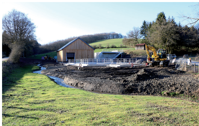
Dei nei Kläranlage zu Brootebach
