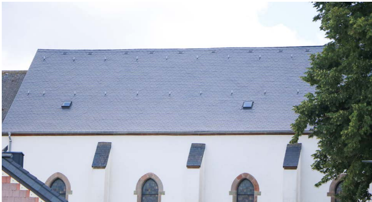
Erneuerung des Daches der Kirche in Boxhorn
