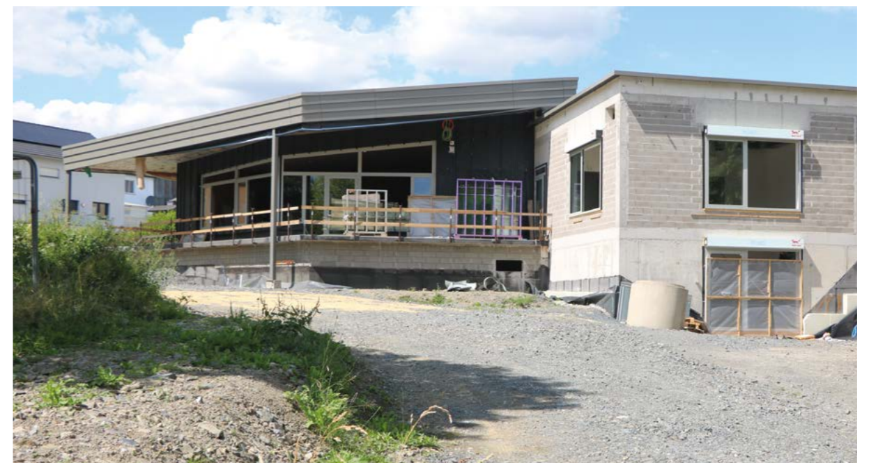
Die Arbeiten am Festsaal in Asselborn laufen weiter und sollen im Frühjahr 2026 abgeschlossen sein.
