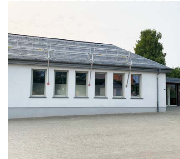
Auf beide Gebäude in Boxhorn (Bäschcrèche und Festsaal) wurde eine Photovoltaikanlage installiert.
