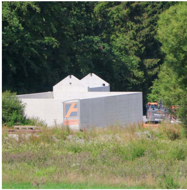
Fortschritte im Bau des Regenüberlaufbeckens in Boxhorn (Boxerbréck).
