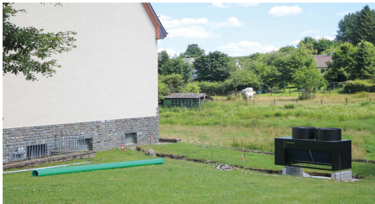
In Hoffelt wurde eine Wärmepumpe für die Kirche eingebaut.
