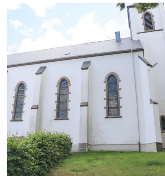
Das Dach der Kirche in Boxhorn wurde erneuert.
