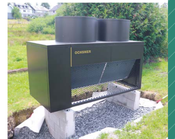
In Hoffelt wurde eine Wärmepumpe für die Kirche eingebaut.
