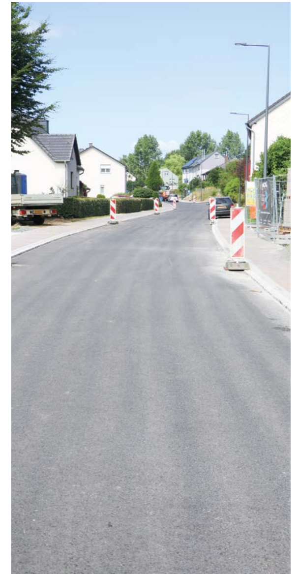
Die Straßenarbeiten in Boxhorn (Hauptstrooss) sind soweit abgeschlossen.
