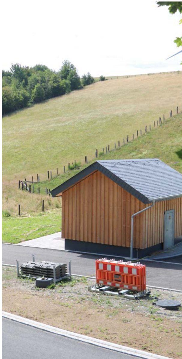
Regenüberlaufbecken in Boxhorn.
