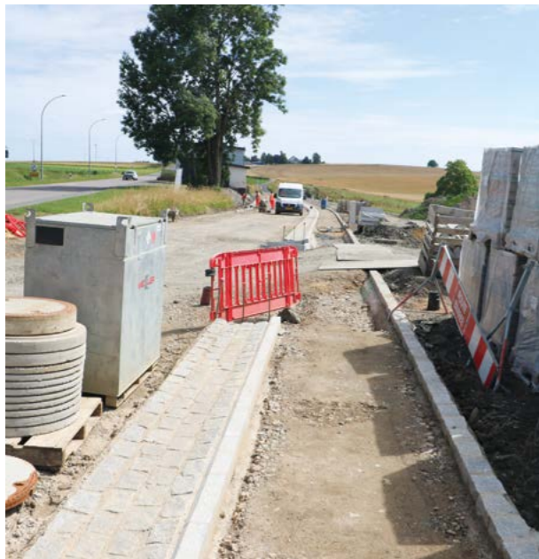
Straßenarbeiten in Heisdorf in Zusammenhang mit dem Bau der bezahlbaren Wohnungen.
