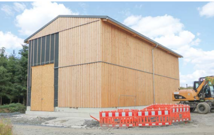
Die Arbeiten am Wasserbehälter in Trottenstraße kommen gut voran.
