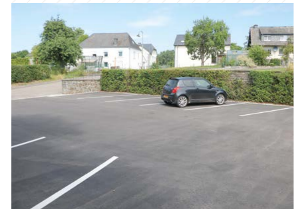
Die Straßenarbeiten in Bögen („Duerefstrooss“ und „Om Bungert“) sind fertiggestellt.
