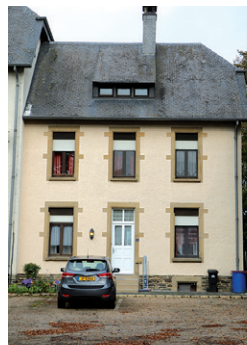
Renovatioun van enger Wunning zu Aasselburren
