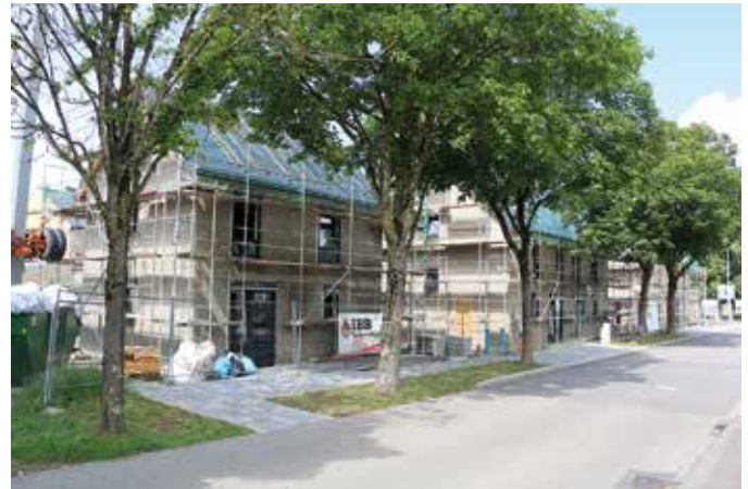
Häuserbau in Hoffelt: In den ersten Häusern wird der Estrich gefertigt und Gipsarbeiten werden durchgeführt.
