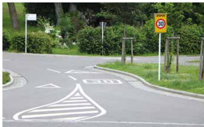
Die Arbeiten zur Einführung der Dreißigerzonen haben begonnen
