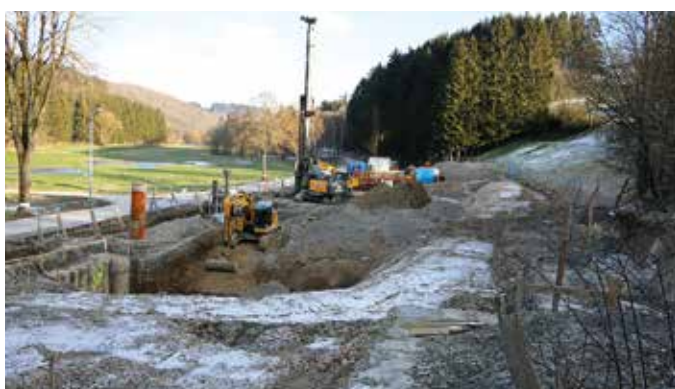
Chantier Kläranlage zu Saassel
