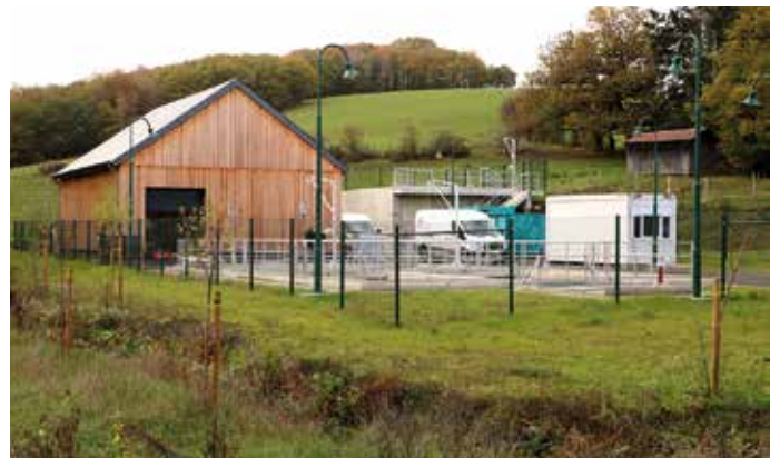
Chantier Kläranlag zu Brotebach.
