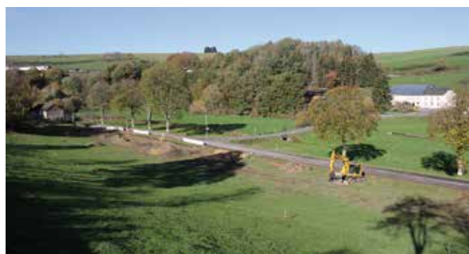
D'Arbichten han zu Saassel agefongen fir de Bau van der Kläranlag.
