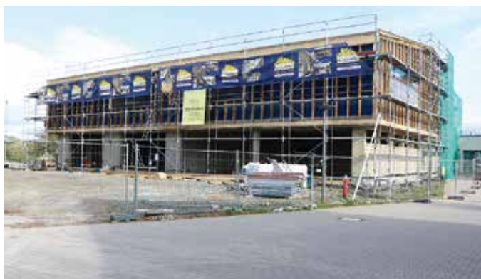
Der Umbau des ehemaligen Schwimmbades geht gut voran. Die Rohbauarbeiten und das Gebälk sind abgeschlossen, die Dach, Heizungs- und Stromarbeiten sind im Gange.
