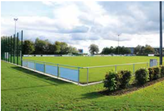
Das Geländer und der Ballfangzaun am Fußballplatz wurde erneuert
