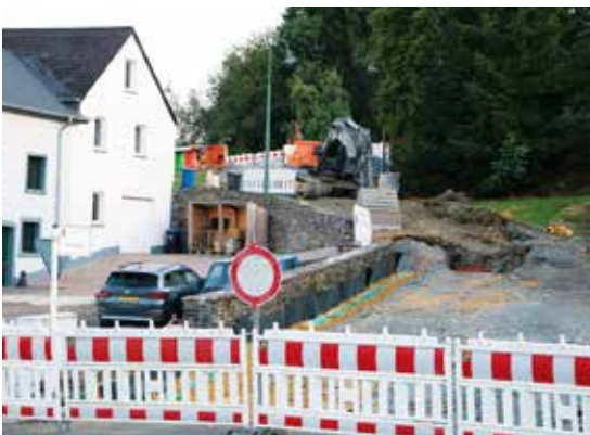
In Boevange wird die Straße „om Knupp“ erneuert
