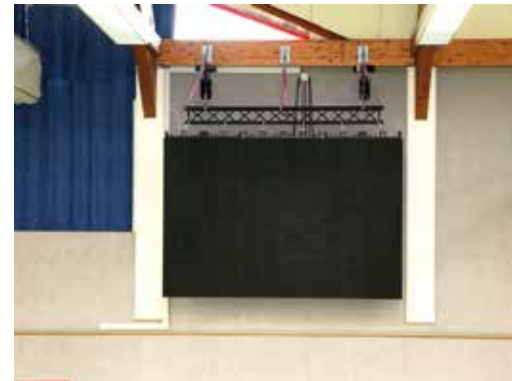
Installation van enger multifunktioneller Leinwand an der Sportshall
