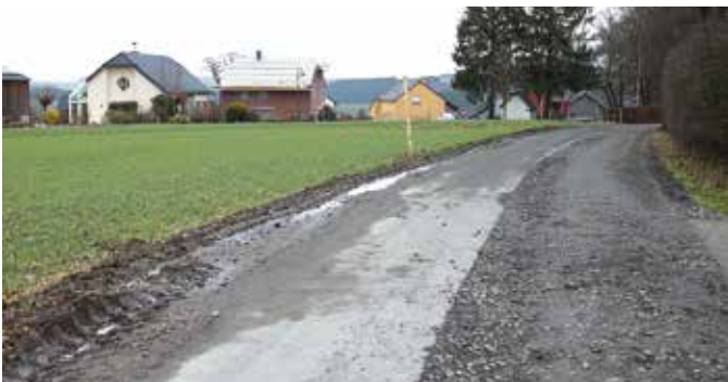
Auf diesem Teilstück in Boegen ist die Druckleitung, von Heisdorf kommend, bereits verlegt worden.
