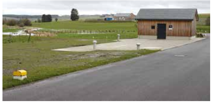
Die neue Kläranlage, sowie der Regenüberlaufbecken in Trothen sind fertiggestellt und in Betrieb.
