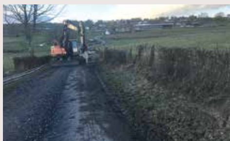
Teschend Heesdref an Béigen gin am Moment d'Drockleitung gelaat deen speiderhin d'Verbinding vum Regeniwverlaafbecken zu Heesdref zu der Kläranlag zu Beigen mecht. Gleichzeitig gin och nach Stroumleitungen mattgelaat.
