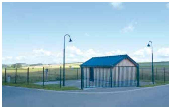
Betriebsgebäude in Troine-Route
