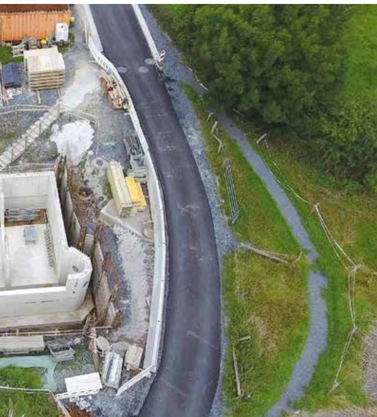
Bau des Regenüberlaufbeckens Allerborn (135m³)
