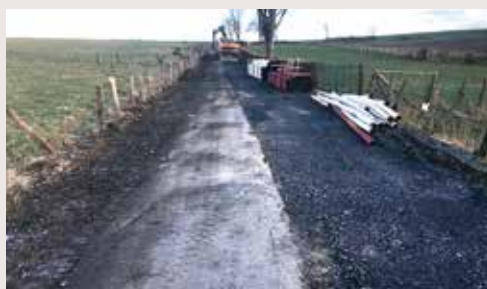
Teschend Heesdref an Béigen gin am Moment d'Drockleitung gelaat deen speiderhin d'Verbinding vum Regeniwverlaafbecken zu Heesdref zu der Kläranlag zu Beigen mecht. Gleichzeitig gin och nach Stroumleitungen mattgelaat.
