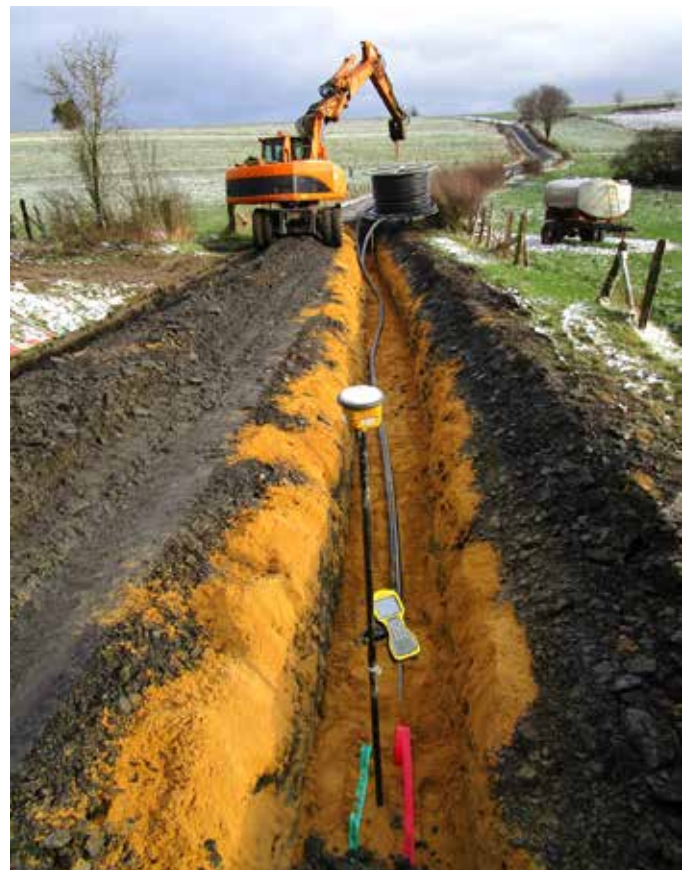
Verlegung der Druckleitungsrohre
