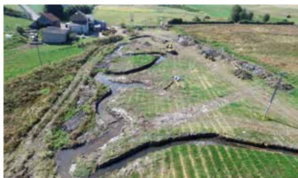
Die Fortschritte der Baggerarbeiten sind bereits gut ersichtlich. Nachdem das Bachbett ausgegraben wurde, wird als nächster Schritt das Wasser umgeleitet und das alte Bachbett aufgefüllt.
