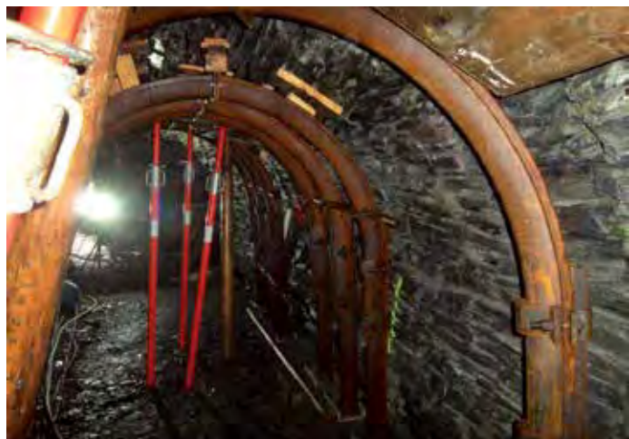
In Emeschbach, in der Schiefergrube, führt eine, in diesem Bereich, spezialisierte Sicherheitsfirma, die Arbeiten aus, um den Stollen zu sichern und als mögliches Kulturerbe zu erhalten.
