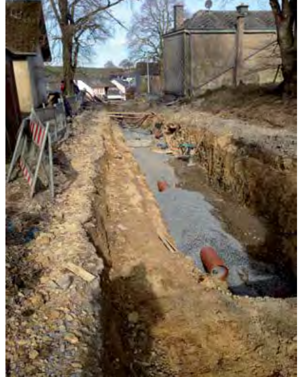
Kanalarbichten an der Strooss Driecht zu Brotebach
