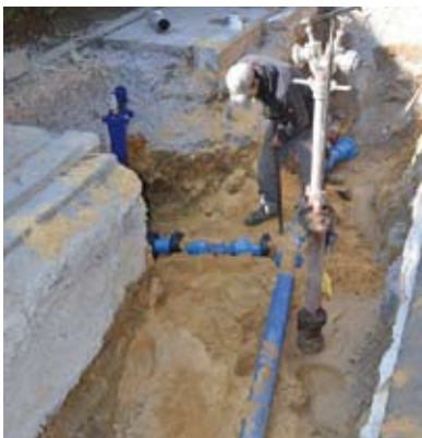
DERENBACH ERNEUERUNG DER WASSERLEITUNGEN
