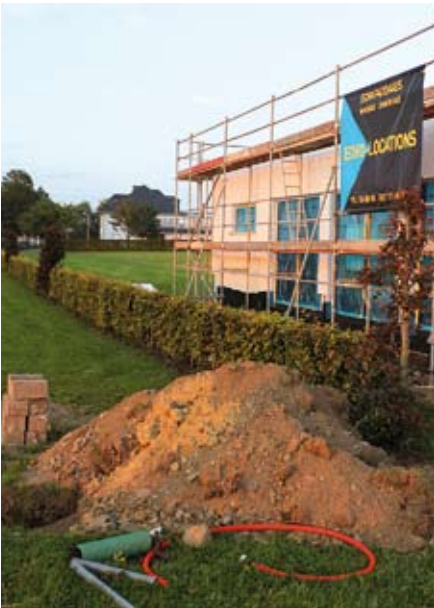
FASSADE VUN DER NEIER APDIKT
