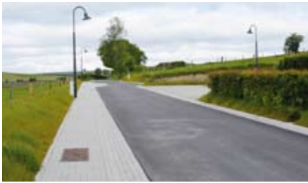
NÉIEN DACH ZU BROOTEBACH
