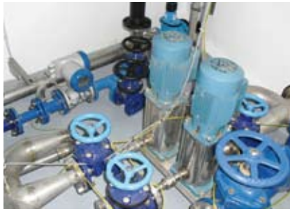
Zwei neue Pumpen ermöglichen einen konstanten Druck von 3,5 bar
