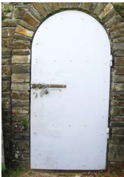
Die Tür war nicht mehr Regelkonform und das Mauerwerk ist mit neuem Mörtel zu verfugen.
