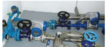
Ein digitaler Zähler wurde eingebaut.
