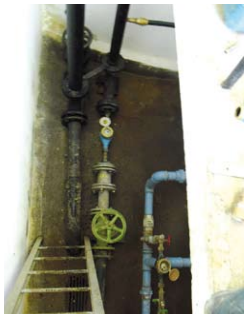
Die alte Stahlleiter zur Schieberkammer.
