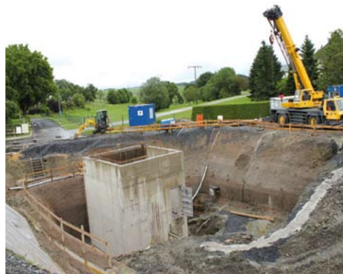
Reeniwerlaafbecken zu Wëntger (Situatioun 25.03.2013)
