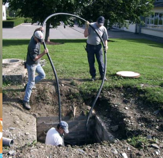
Verlegung des Starkstromkabels
