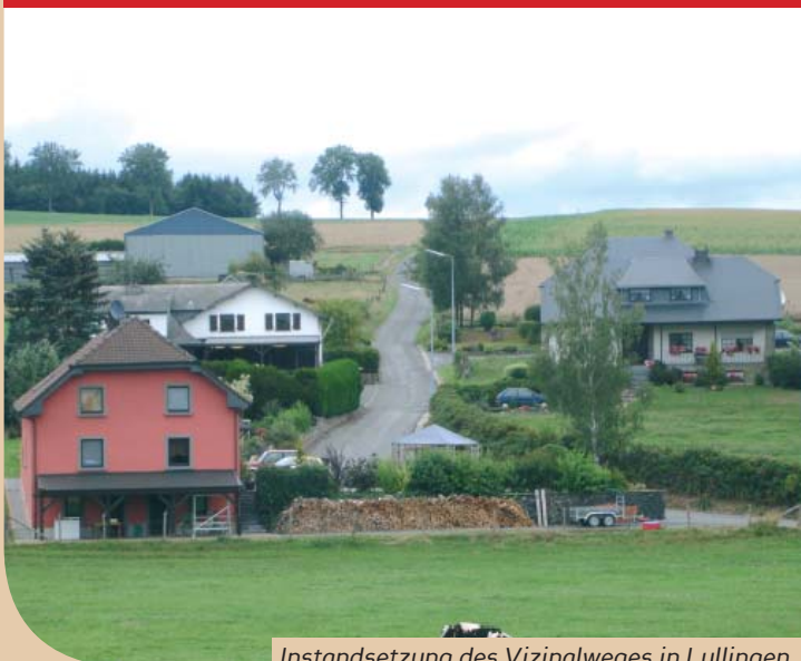
Instandsetzung des Vizinalweges in Lullingen.
