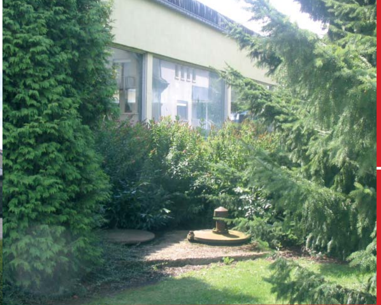
Der bestehende Wasserbehälter.
